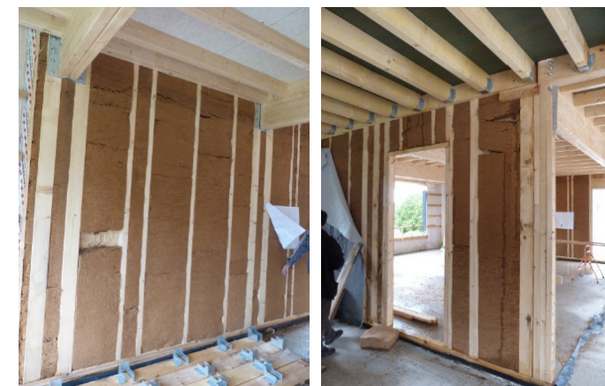
Tassement de la fibre de bois suite à une arrivée d'eau en toiture en cours de chantier.
