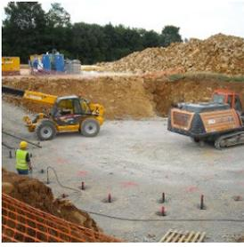
► Une mauvaise connaissance de l'hydrogéologie du site peut engendrer des défauts de dimensionnement ; le massif de fondation, s'il est baigné dans une nappe, subit des poussées d'Archimède, à prendre en compte dans les calculs de conception ; lorsque la fondation est dans l'eau,
