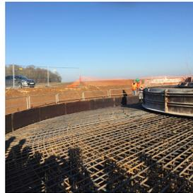
► Un défaut de réalisation de l'ancrage de la cage d'armature du mât de l'éolienne, peut engendrer un sinistre sur le mât de la machine de type corrosion.
