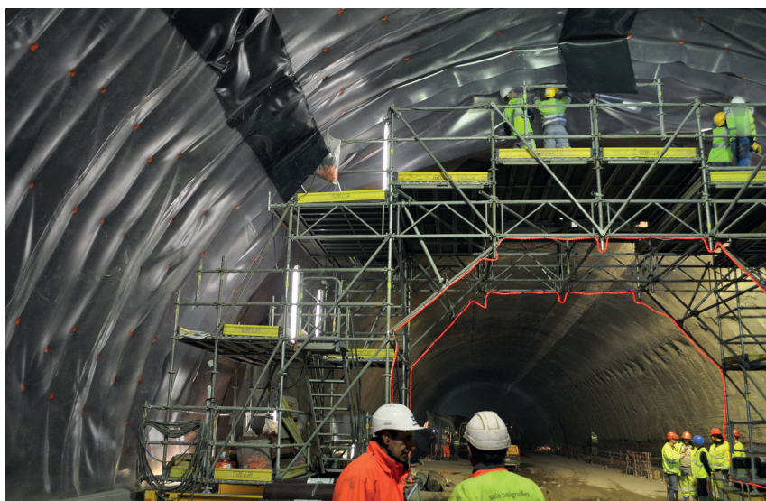
Mise en place d'une géomembrane synthétique en tunnel en extrados avant mise en place du ferrailage, masque/coffrage et coulage béton.
