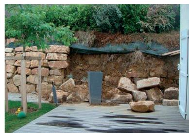
Chute d'un mur de soutènement
