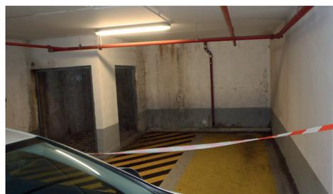
*infiltrations à travers le radier ainsi que par la paroi moulée. Source SOCATAT*
