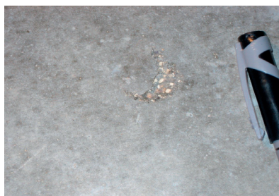
Eclatements coniques (popouts) et exsudations de gels sur dallage.
