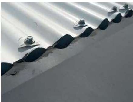
Détail rive haute jonction panneaux - tôle ondulé
