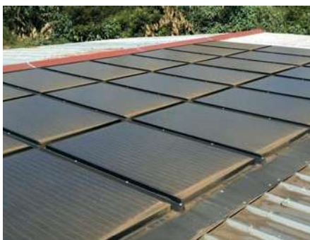
Pente insuffisante - défaut étanchéité - accumulation poussière en bas de panneaux.
