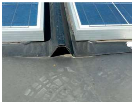
Absence de complément panneaux - tôle égout.
